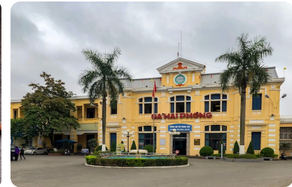
Hai Phong – La gare ferroviaire
