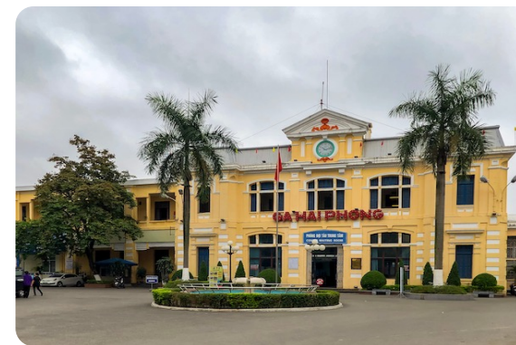
Hai Phong – La gare ferroviaire
